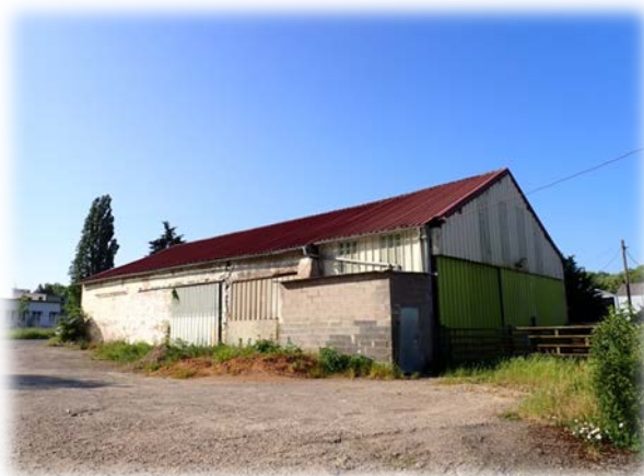
Bâtiments avec murs en pierre
