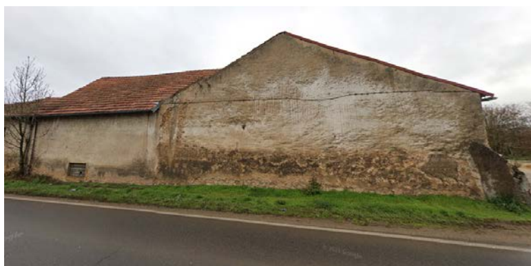
Façade sud du bâtiment agricole
