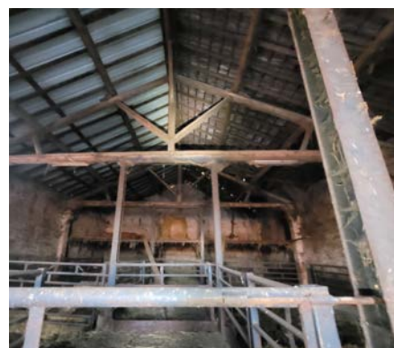
Intérieur du bâtiment agricole
