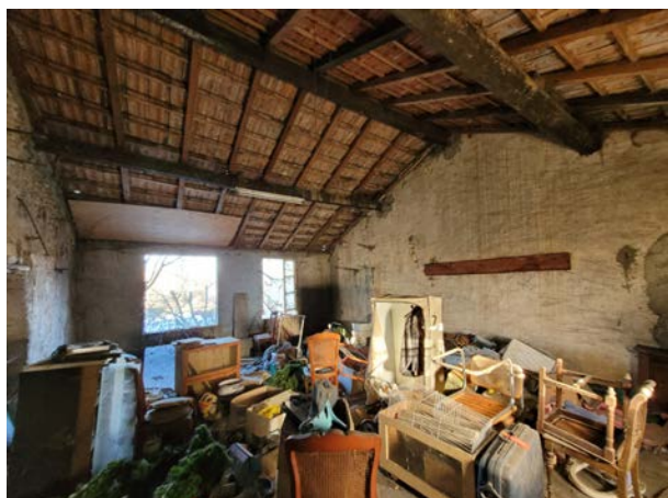
Premier étage / comble de l'ancienne grange attenante au bâtiment agricole
