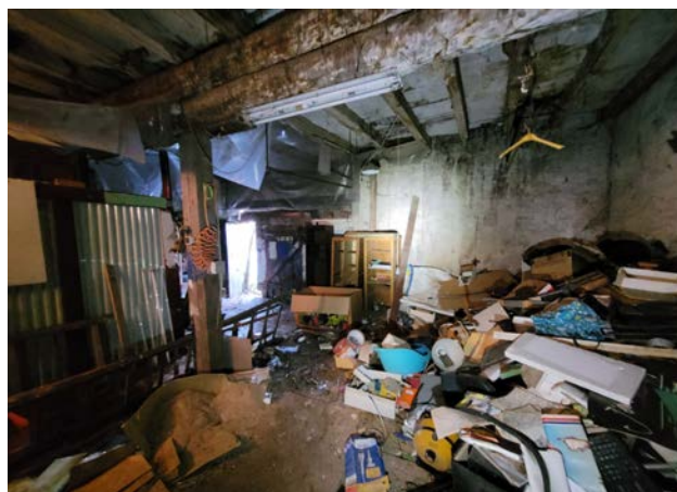
Rez-de-chaussée de l'ancienne grange attenante au bâtiment agricole
